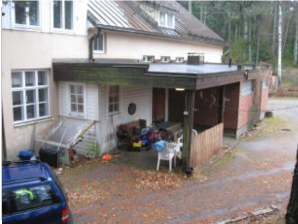
7. Laajennusosa, itä- ja pohjoissivut
