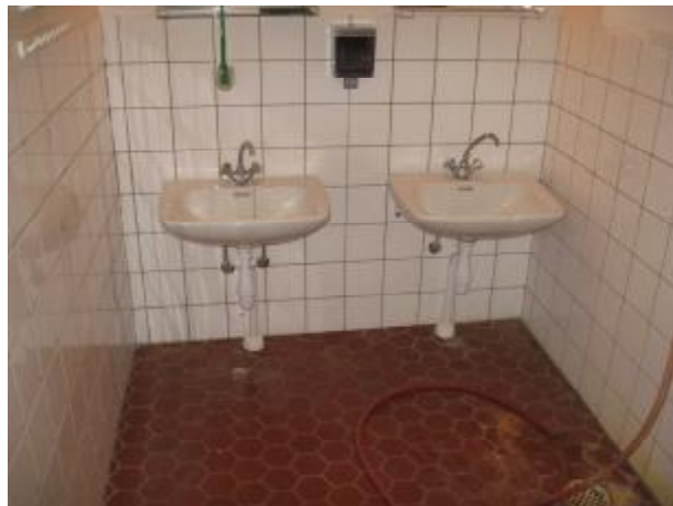
32. Poikien wc-tilojen etuhuone
