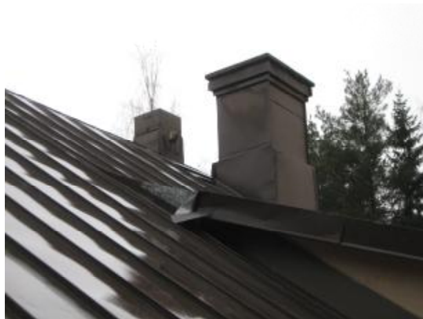
22. Vesikattoa, keskuslämmityskattilan savupiippu ja veistosalin maalaamon huippumuri
