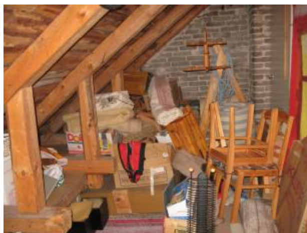
24. Länsipään asunnon sivu-ullakko
