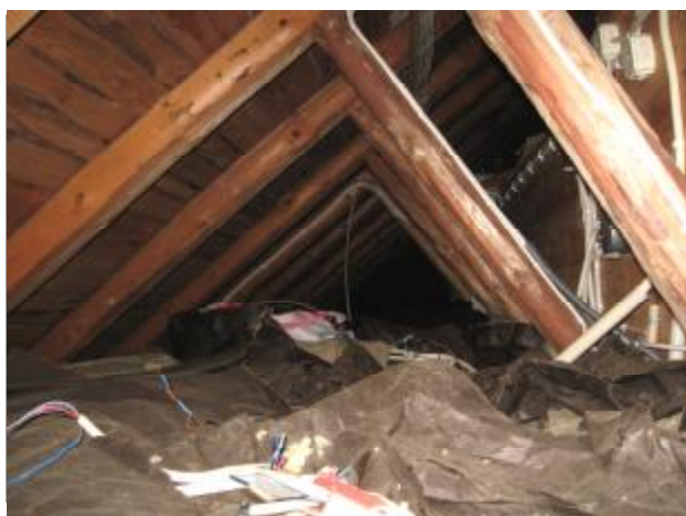
23. Itäpään yläpohjan onteloa
