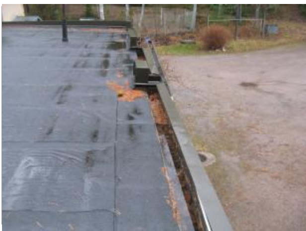
17. Laajennusosan vesikatto, ulkopuolinen vedenpoisto kouruin ja syöksytorvin
