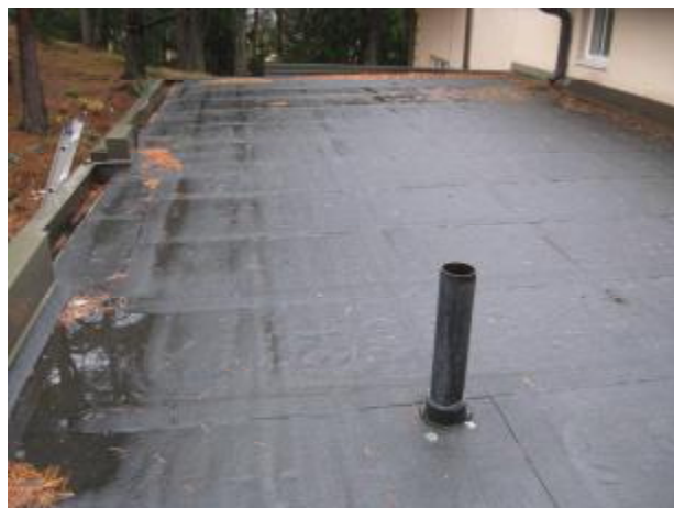
16. Laajennusosan vesikatto, viemärin tuuletusputki
