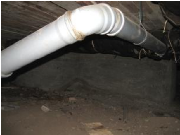
13. Itäpään alustatila, uusittu viemäri
