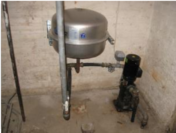
27. Vesipumppu ja painesäiliö, kellarissa
