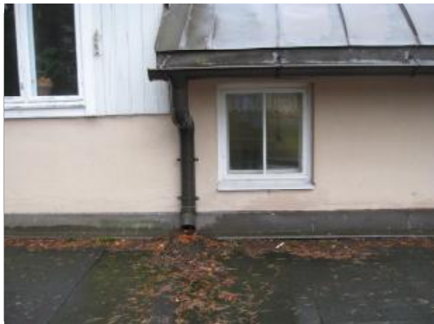
19. Ylemmän katon vedet on johdettu syöksytorvella laajennusosan katolle
