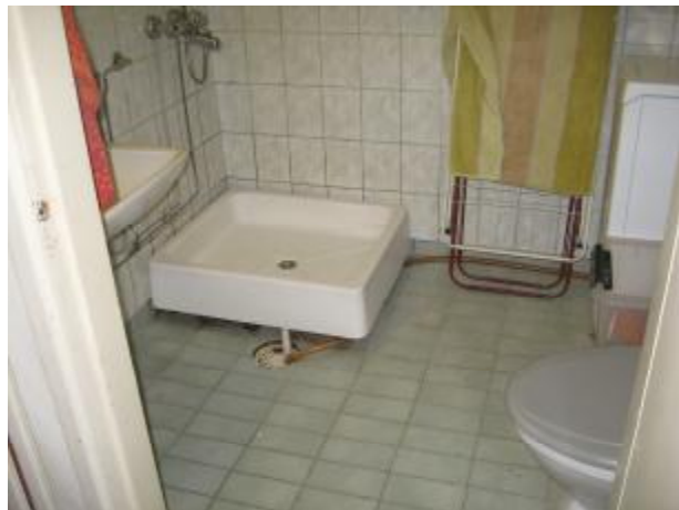
44. Ullakkokerroksen itäpään asunnon kylpyhuone
