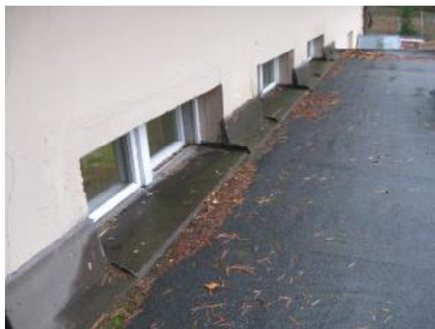
18. Koulun aulan yläikkunat lähellä laajennusosan vesikaton tasoa
