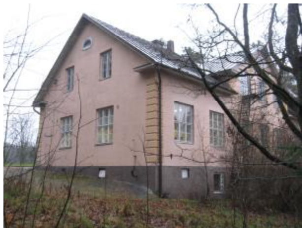
4. Länsipääty ja eteläsivu
