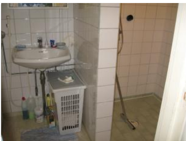
47. Ullakkokerroksen länsipään asunnon kylpyhuone, suihku-tila oikealla
