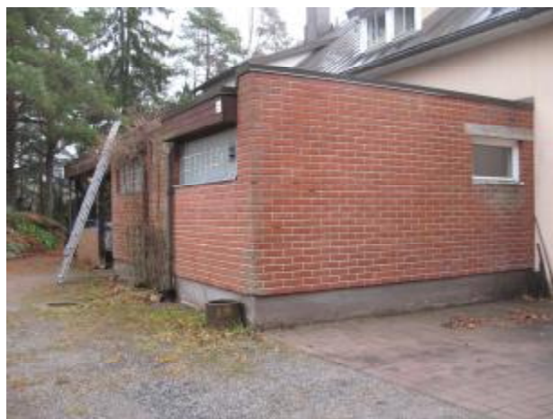
6. Laajennusosa (wc-tilat), pohjois- ja länsisivut
